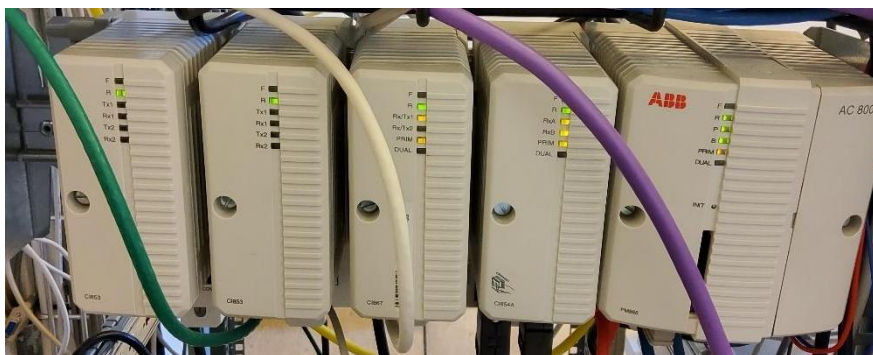
Figur 8: Från vänster till höger syns kommunikationsmodulerna CI853, CI853, CI867, CI854A, följt av CPU modulen PM866 för styrsystemet AC800M. (Hämtad från Landskrona fältinstrument)
